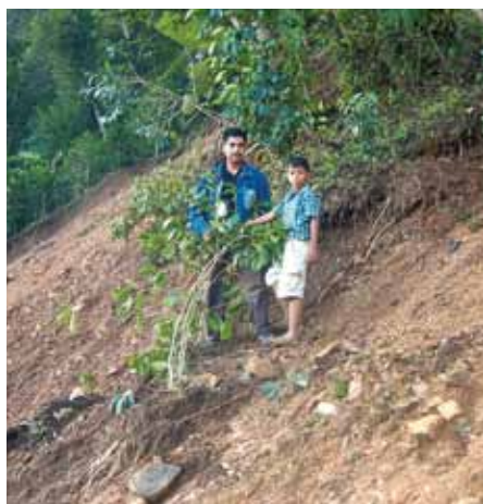
Con pendientes extremas las laderas se deslizan
