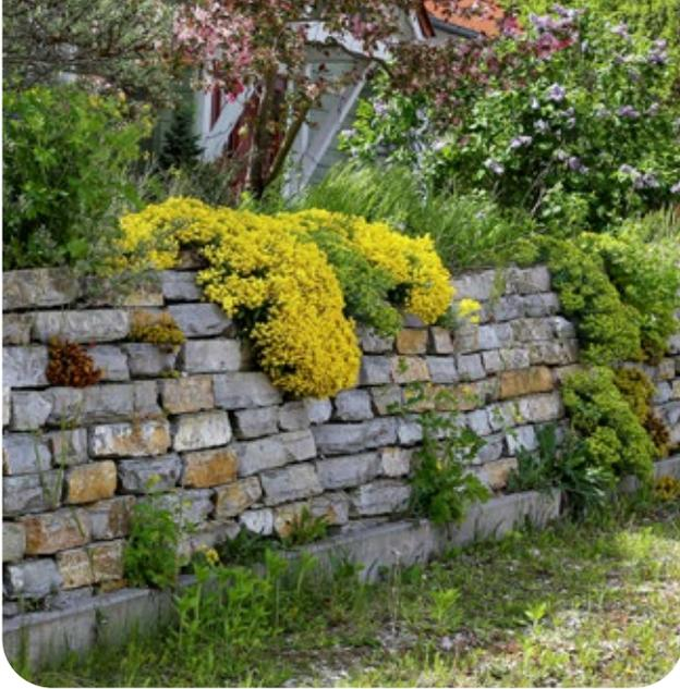
Trockenmauern sind Mauern, die ohne Verwendung von Mörtel aus behauenen oder unbehauenen Natursteinen gefertigt sind. Sie wurden früher im Weinanbau, zum Schutz von Siedlungen und Gehöften und als Zäune und Grenzen in den unterschiedlichen Techniken erbaut. Trockenmauern sind ästhetisch ansprechende, vom Menschen gemachte Biotope, die Insekten, z. B. Hummeln und Spinnen, Zauneidechsen, Blindschleichen und der Flora trockener Standorte Lebensraum bieten.
