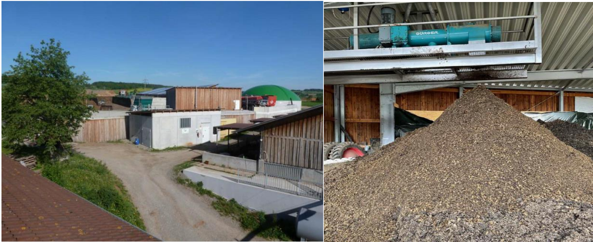
Figure 13. Biogasanlage mit Technikraum, Silos, Gärbehälter, Endlager und Gasspeicher (links) und Abscheider der Feststofffraktion (rechts; E. Räder)
